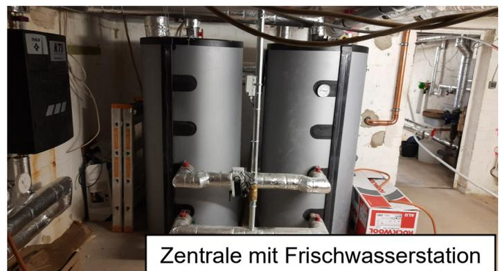
Zentrale mit Frischwasserstation
