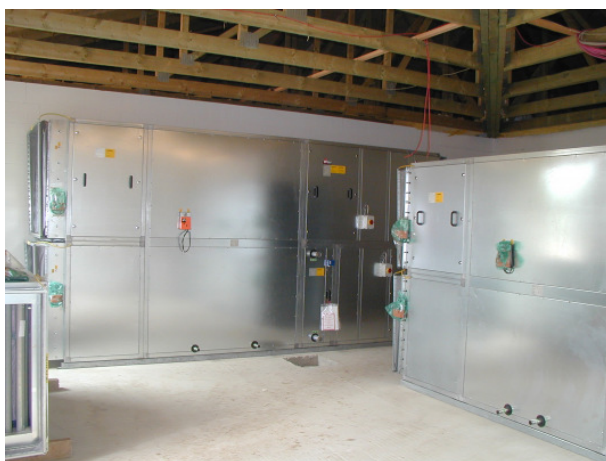
Technikzentrale mit den RLT-Anlagen Speisessal und Nebenräume Küche
